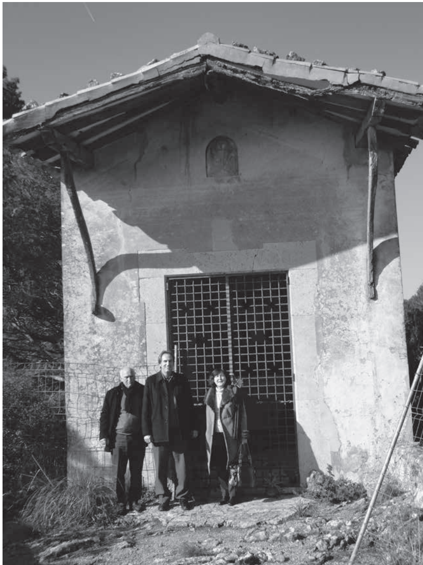
Capilla de la Beata Catalina Tomás en restauración, en valdemossa.
